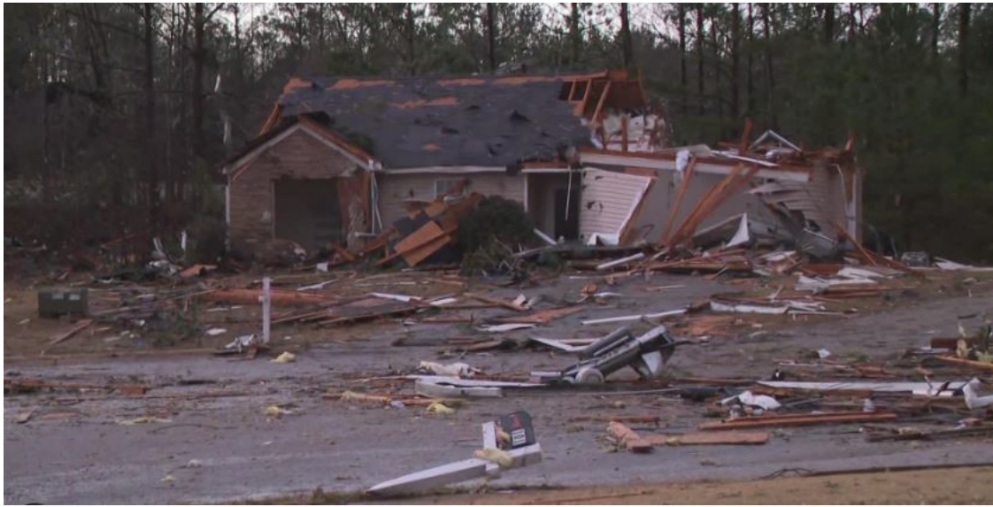
Hình - Ngôi nhà bị hư hại tại Quận Troup. Nguồn: 11 Alive News
