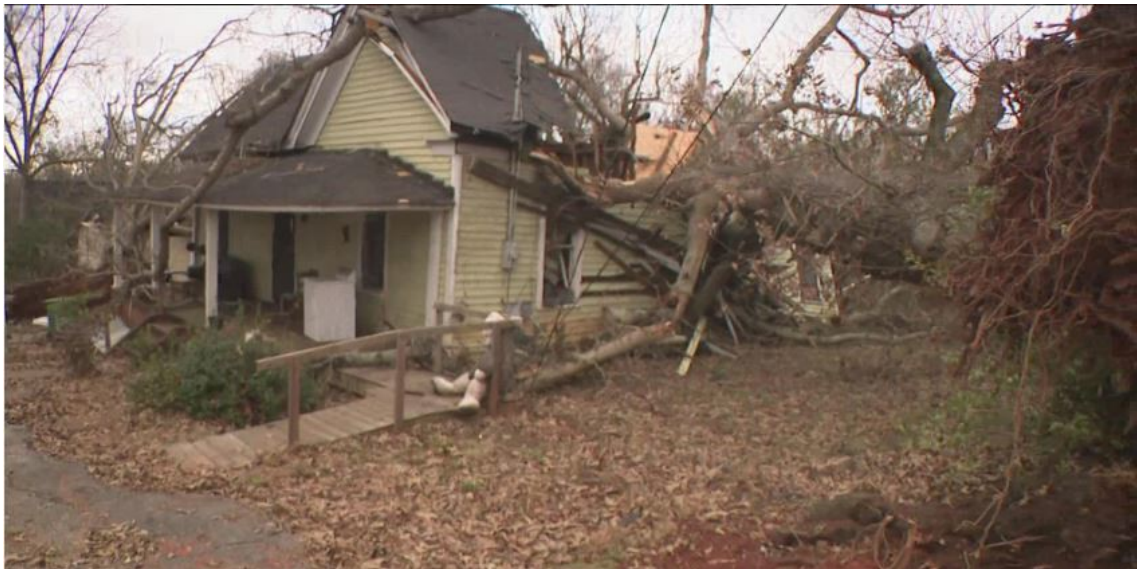
Hình - Ngôi nhà bị hư hại tại Griffin. Nguồn: 11 Alive News
